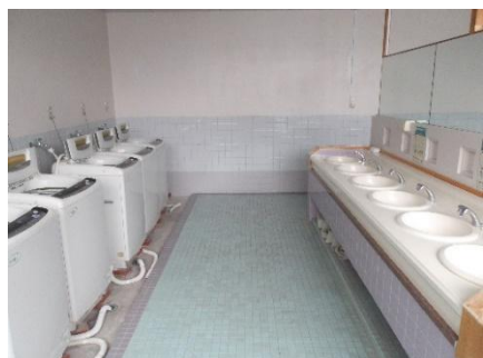
洗濯機の設置
