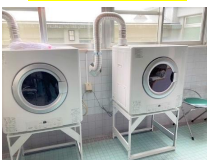
乾燥機の設置
