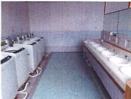
洗濯機の設置
