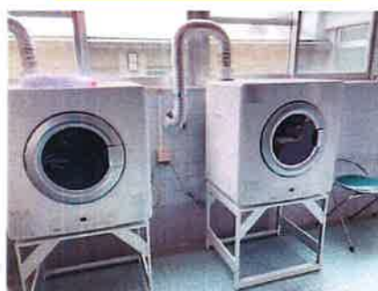
乾燥機の設置
