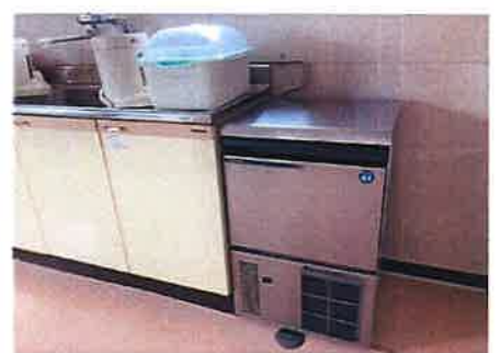
製氷機の設置
