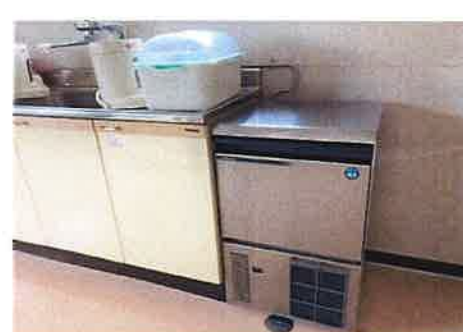
製氷機の設置
