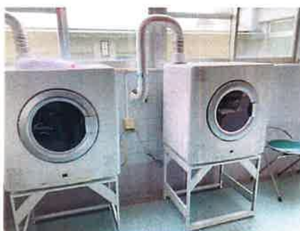
乾燥機の設置
