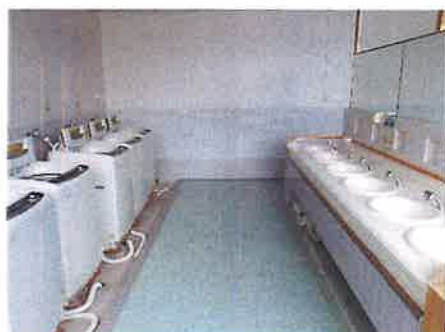
洗濯機の設置
