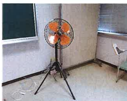
各研修室に扇風機を設置
