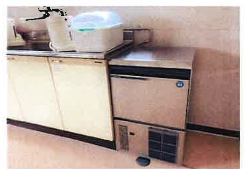
製氷機の設置
