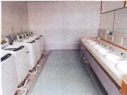
洗濯機の設置
