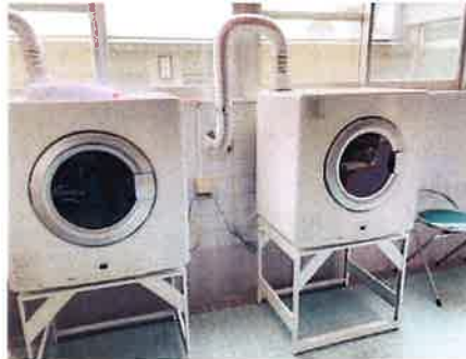
乾燥機の設置
